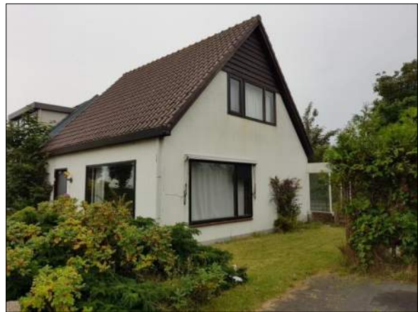
Figuur 4. Woning aan Schoolweg 20
