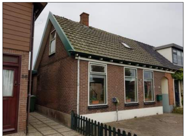
Figuur 6. Woning aan Schoolweg 24
