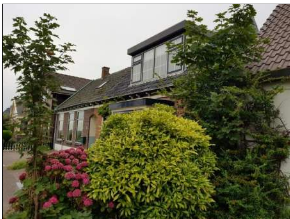
Figuur 5. Woning aan Schoolweg 22
