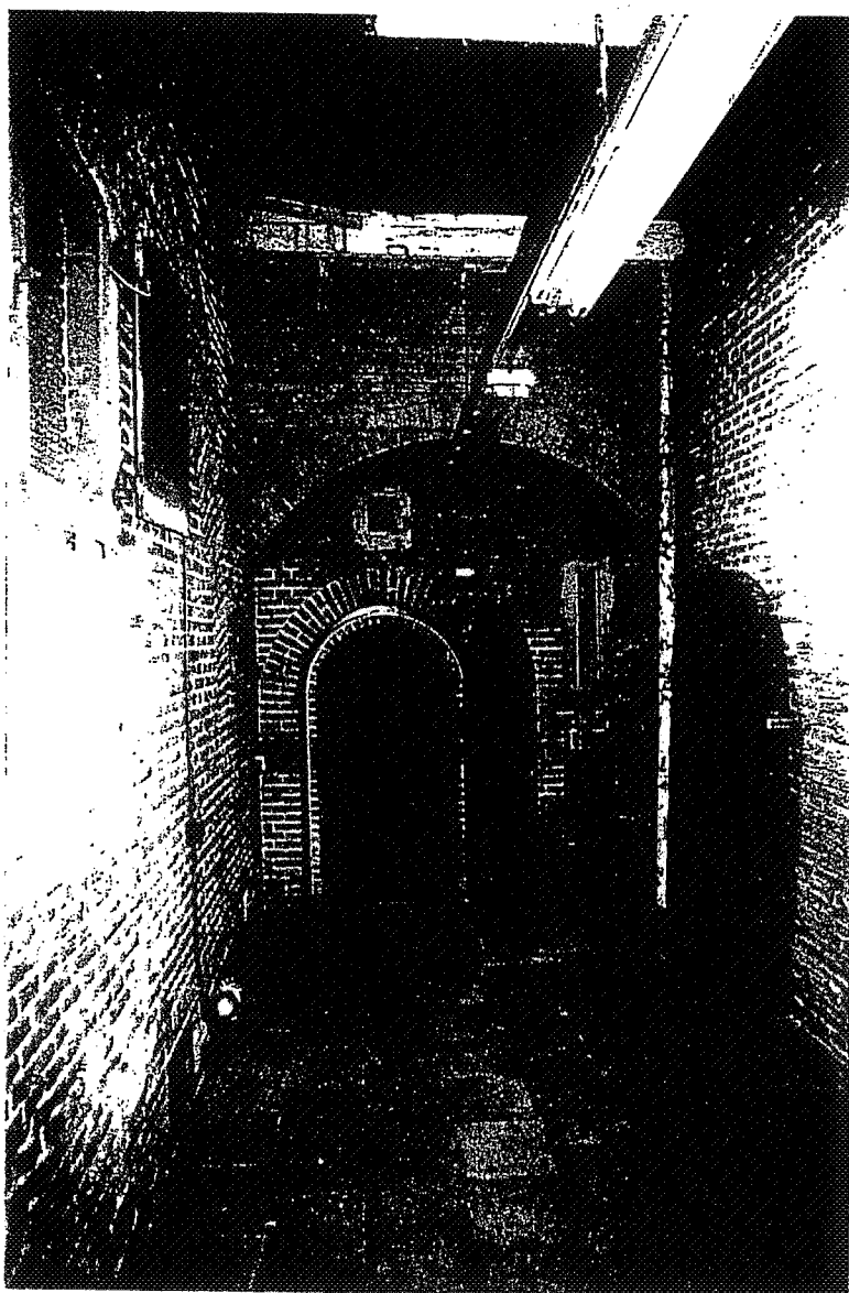
Afb. 074.10 De muren waarin zich de toegangen tot de kruitmagazijnen bevinden zijn haaks op de achtersluitmuur geplaatst. De getoogde doorgang (A) is uitgevoerd met een sponning met sluit- en duimstenen voor de deur, die recent is vervangen. Naast de doorgang bevinden zich twee smalle ventilatie-openingen (B) boven elkaar, die gelijk zijn aan die in de poortdoorgang. Boven de deur is een vergelijkbare, kleinere opening (C) opgenomen. Geen van de openingen ventileert rechtstreeks de achtergelegen ruimte, maar waarschijnlijk via een spouw. De luchtboog (D) tegen de muur is bij het plaatsen van de keermuur in 1875-1878 met drie anderen aangebracht om de gronddruk op te vangen (zie afb. 074.1 en 074.2).
