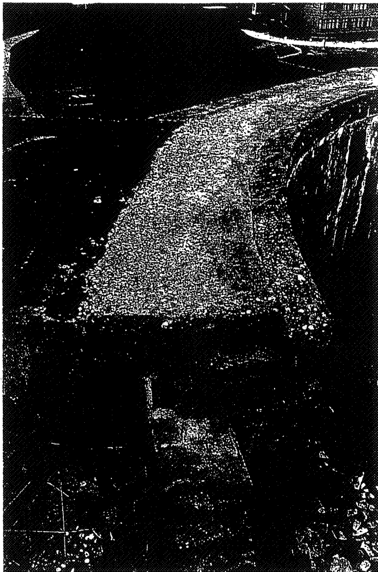
Afb. 069.10 Detail van de ingang van de zuid-oostelijke bedding. Waarneembaar is dat de wand van de bedding is uitgevoerd in baksteen (A) afgesmeerd met mortel en de nissen (B) zijn uitgevoerd in beton. Ook is een wijziging te zien van de rand (C) die waarschijnlijk is uitgevoerd door de Duitsers als aanpassing voor het plaatsen van geschut.
