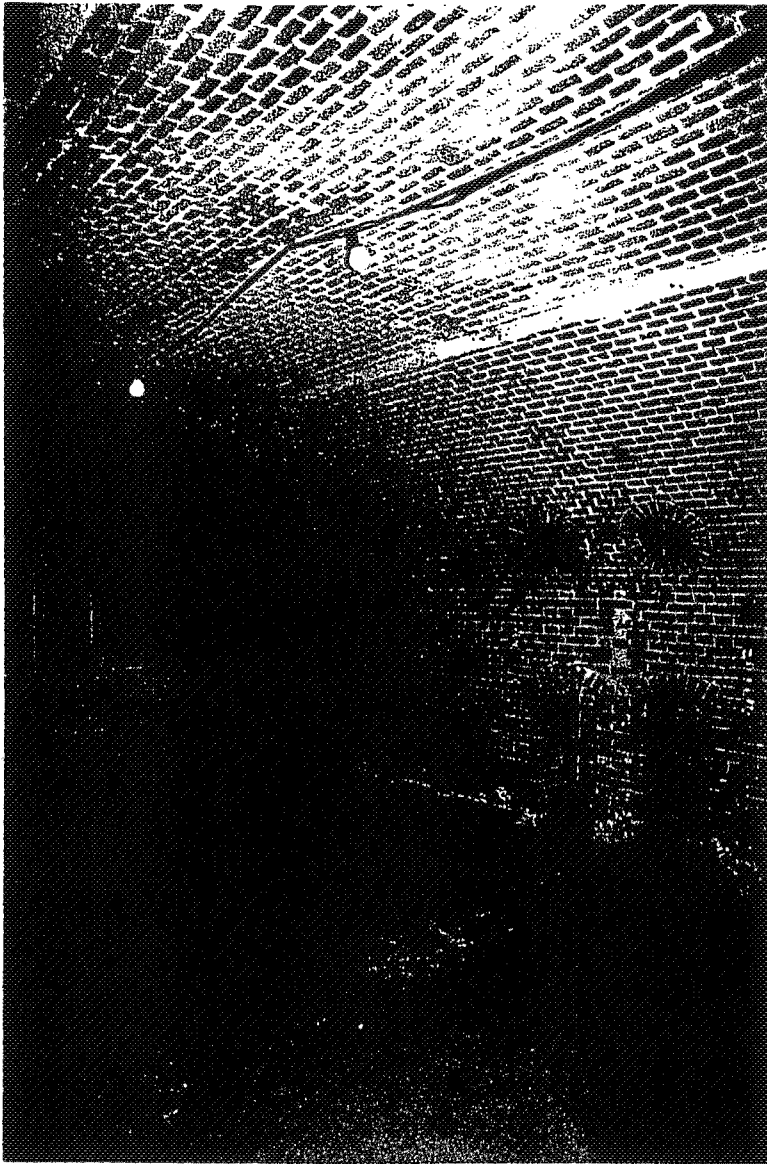
Afb. 061.21 Ruimte 51. De middelste kazemat van de middelste vier kazematblokken was in opzet gedeeld door een muur (A) op ongeveer een derde voor de voorsluitmuur. Aan weerszijde van de deelmuur is daarbij een stookplaats (B) gesitueerd. Deze stookplaatsen zijn uitgevoerd als getoogde nissen voor kachels, waar boven in het gewelf een ronde opening (C) is gemetseld voor de trek. Op de meeste plaatsen is het metalen rooster om de openingen af te sluiten nog aanwezig. Tevens bevinden zich onder ruimte 16 en 51 de waterkelders van het gebouw, die middels openingen (D) in de vloer van de ruimten toegankelijk zijn.
