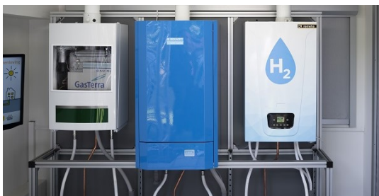
Ombouwen decentraal aardgas-netwerk naar H 2 -netwerk door een energiebedrijf, installatiebedrijf, woningstichting en netbeheerder.
