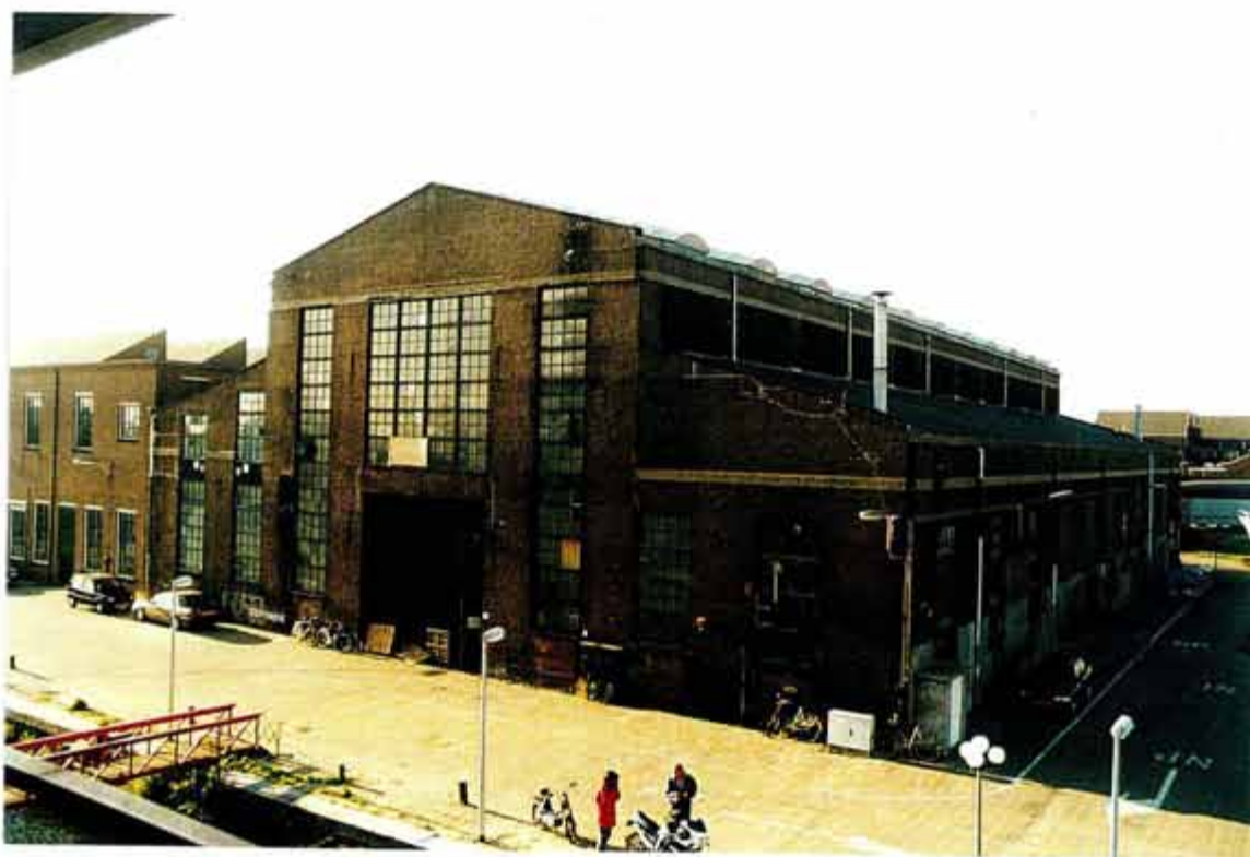
Afb. 7 Overzicht van de zuidgevel. De gevel (zie afb. 2) is grotendeels origineel afgezien van de gewijzigde deur en de verhoogde vensters in de westelijke beuk.
