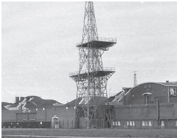
de voormalige NAVGIS (oostbatterij) was geïntegreerd in de zeewering (gesloopt in 1975)
