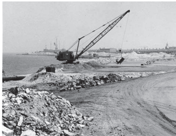
aanleg van de dijkversterking (1976)
