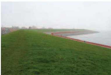
dvoor de uitbollingen van de zeevering is de dijk herkenbaar onderdeel van de Stelling
