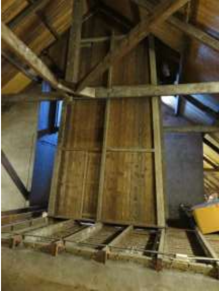
30 en 31 - Kapconstructie en houten lichtschacht zolder en bovenlicht van glas in lood (bouwdeel A)
