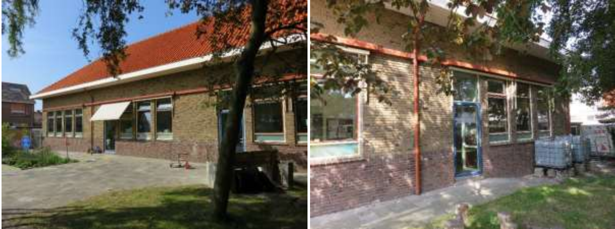
23 en 24 – Linker geveldeel achtergevel bouwdeel C en rechterdeel achtergevel bouwdeel C/A.
