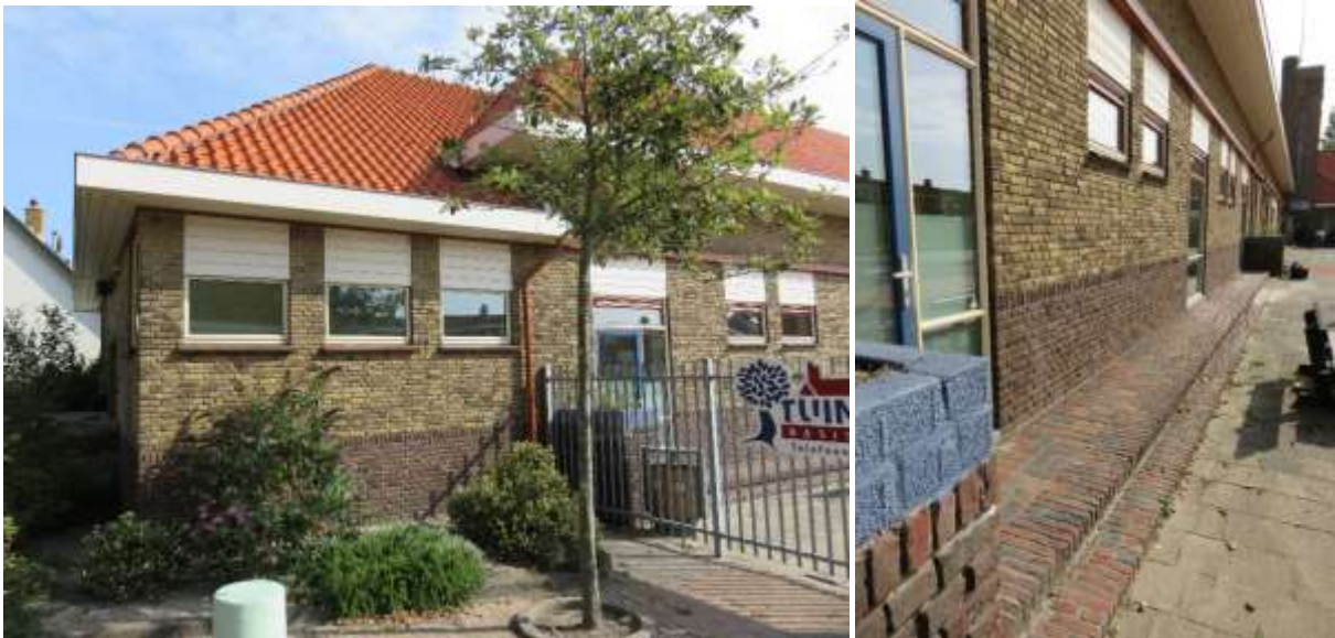
17 en 18 – Linker geveldeel rechterzijgevel van bouwdeel A en detail hoek bordes bouwdeel A
