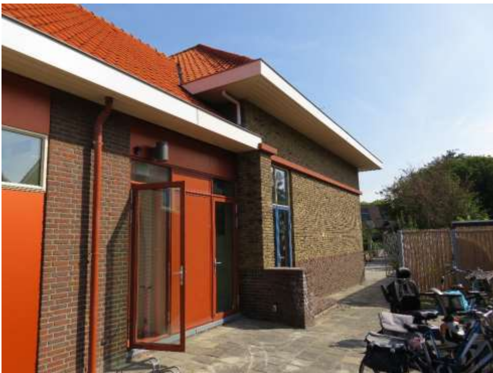
22 - Rechterzijgevel bouwdeel C, met links daarvan de latere aanbouw uit 1984
