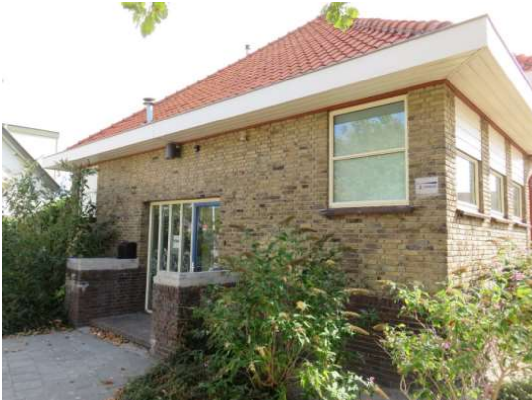
12 - Voorgevel bouwdeel B
