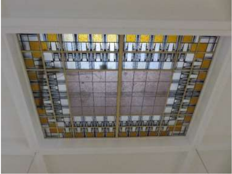
30 en 31 - Kapconstructie en houten lichtschacht zolder en bovenlicht van glas in lood (bouwdeel A)
