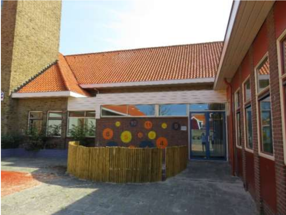
21 - Voorgevel bouwdeel C
