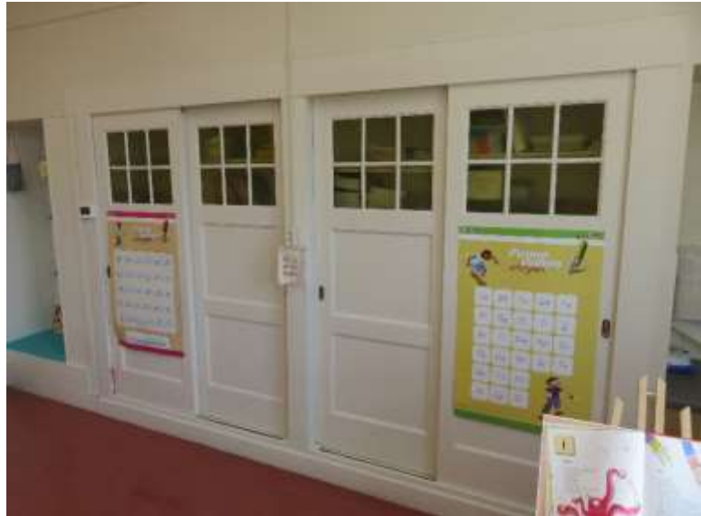
26 en 27 - Gang met tegelvloer in westvleugel en originele wandkasten met houten paneeldeuren met zesruits venster
