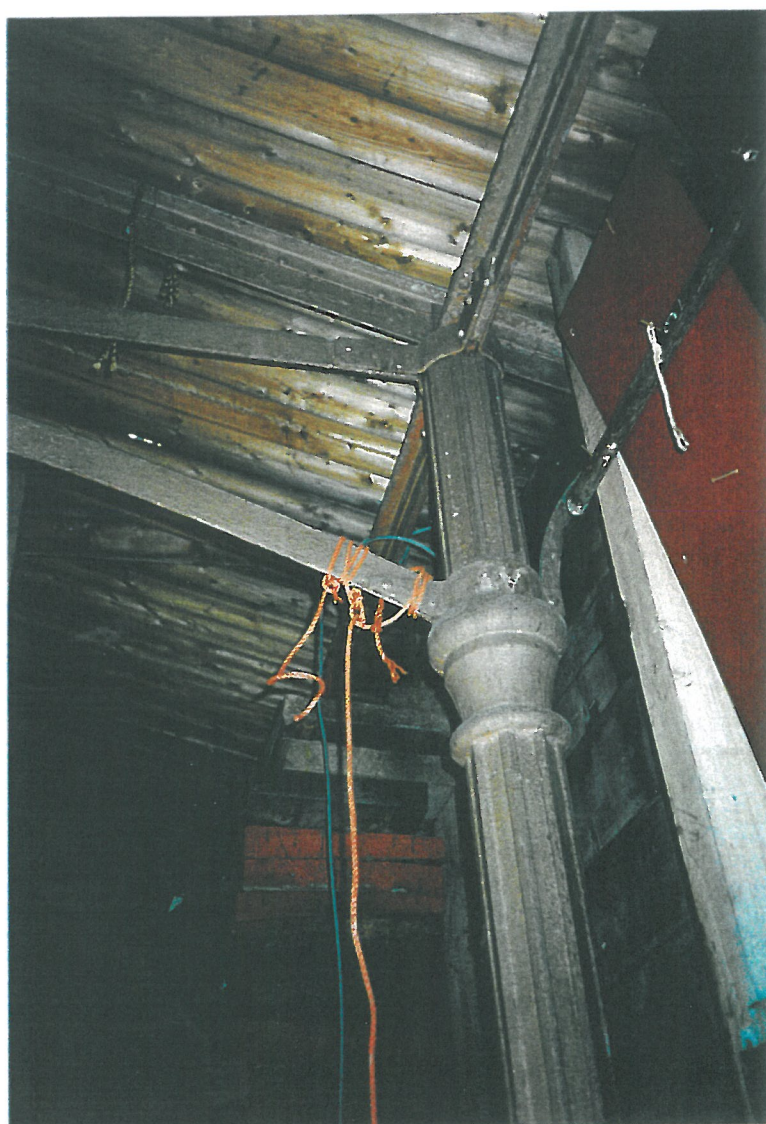
Afb. 3 Detail van een gietijzeren kolom met de aansluiting op het spant. Deze kolommen, met cannelures en kapitelen, dateren uit de bouwtijd: 1868-70.
