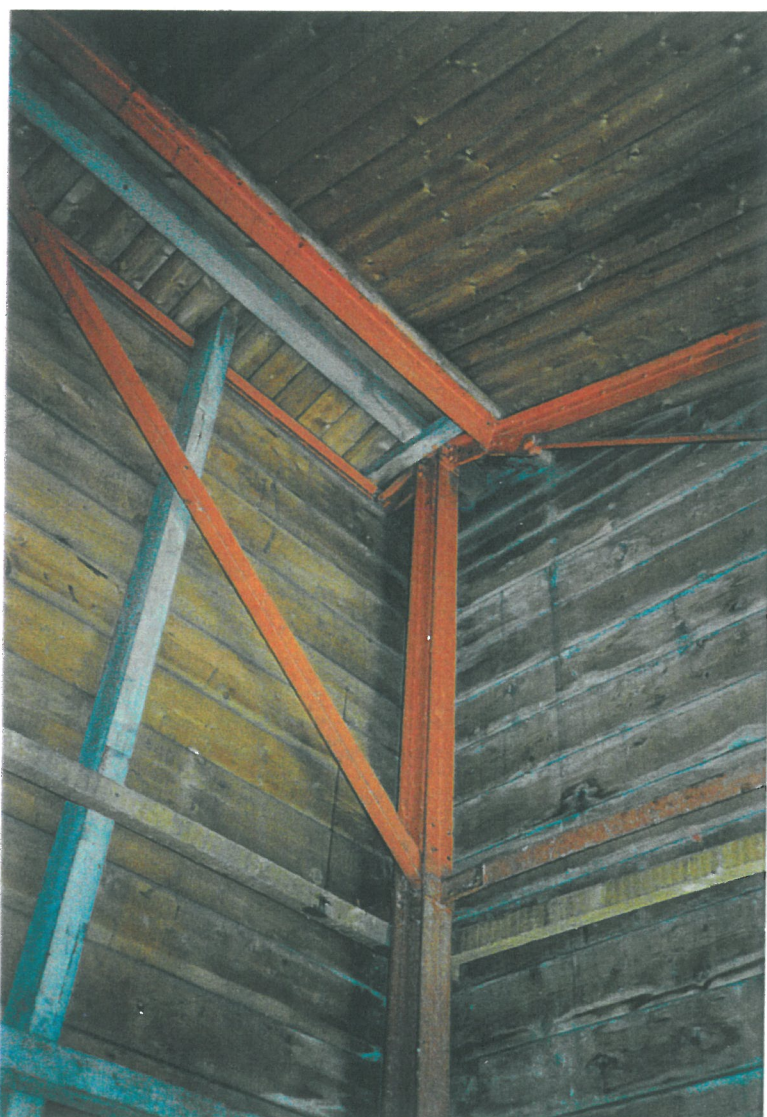
Afb. 4 Detail van een gesmede H-kolom. Deze kolommen staan in het midden ter ondersteuning van de spanten en nokbalk. De kolommen zijn samengesteld uit een middenflens en vier hoekprofielen, waardoor een H-vorm ontstaat.
