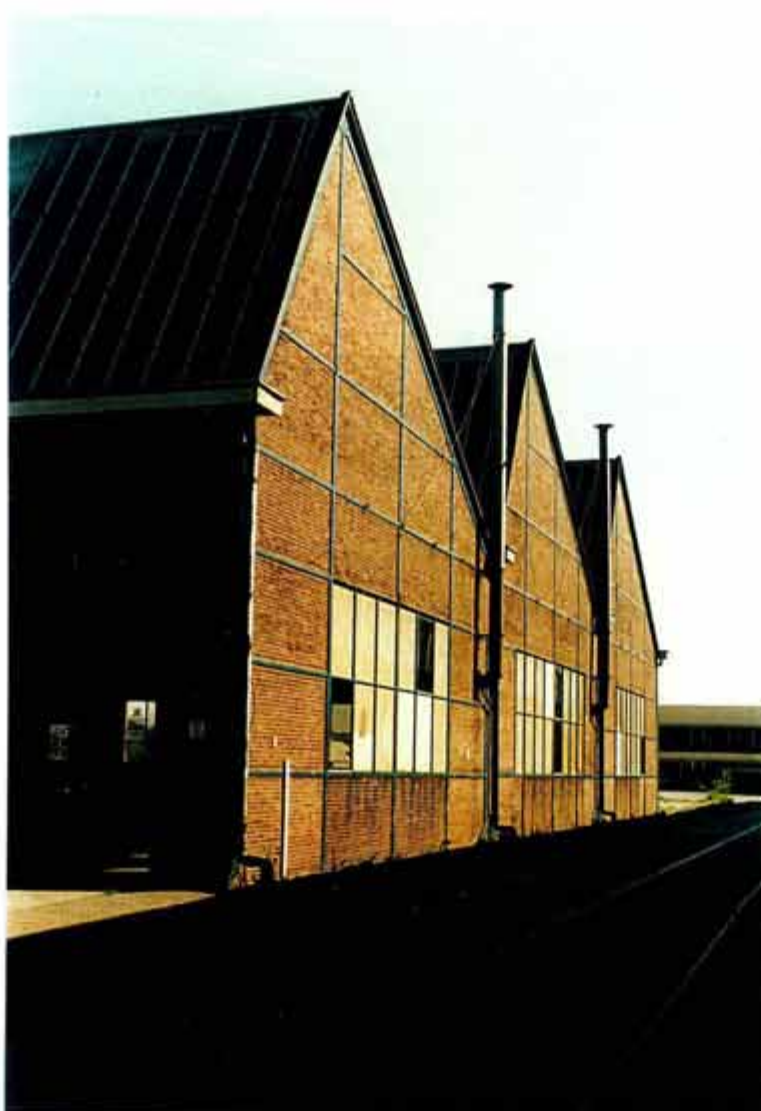
Afb. 13 De westgevel van gebouw 51, gezien vanuit het noordwesten. Dit is de kopgevel van de lage driebeukige hal uit 1938-'39. Zowel de kopgevels als de lange gevels zijn opgebouwd uit een stalen frame waarin baksteen als vulling is aangebracht. De sheddaken zijn aan de noordzijde voorzien van glaspanelen (thans kunststof) en aan de zuidzijde van een betonnen bedekking.
