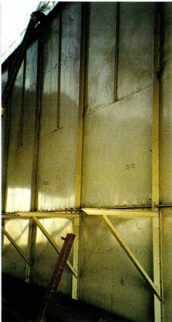
Afb. 22 (links) Op de eerste verdieping van de eenbeukige hal van gebouw 51, daterend uit 1951-'52, bevindt zich deze geklonken ijzeren tussenwand (zie ook afb. 23).
