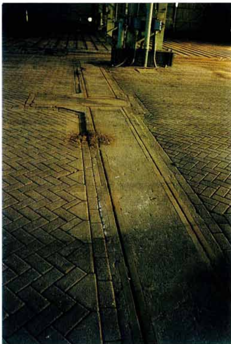
Afb. 18 Gedeelte van het smalspoor in de driebeukige lage hal van gebouw 51. Op de achtergrond is nog een draaischijf zichtbaar.
