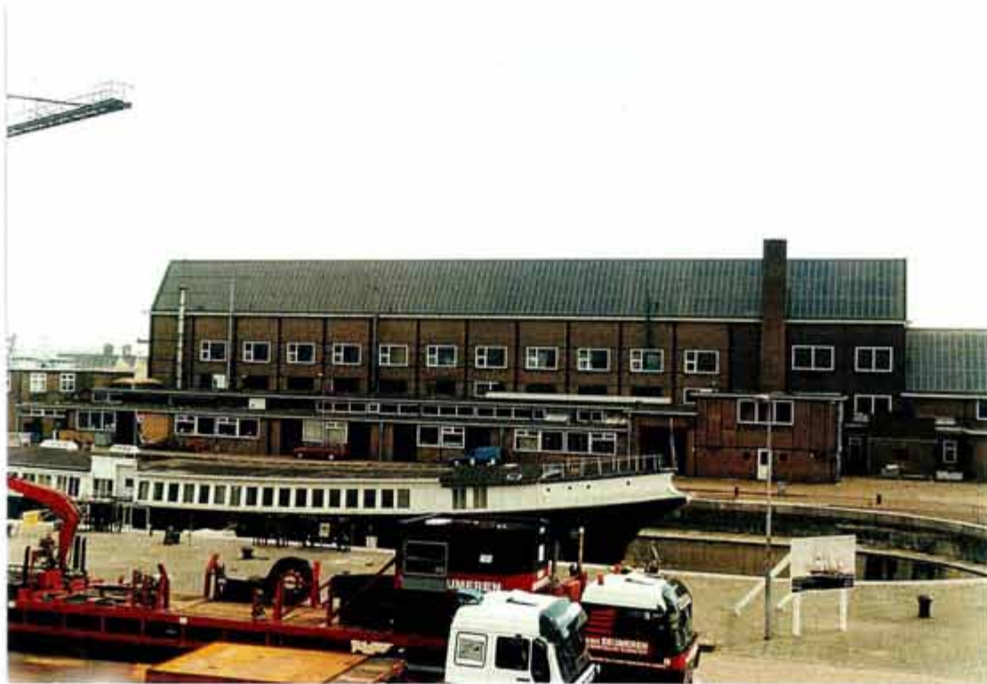
Afb. 15 De noordgevel van gebouw 51. Uiterst rechts is een deel van de lage driebeukige hal uit 1938-'39 zichtbaar, met direct daarop aansluitend de uit drie traveeën bestaande hoge driebeukige hal uit dezelfde tijd. Links daarvan bevindt zich een eenbeukig gebouw, dat in 1951-'52 tegen de driebeukige hal is gebouwd. Vóór dit gebouw zijn de aanbouwen met plattendak uit 1951-'52 zichtbaar. De gevels bestaan uit een stalen frame met een baksteenvulling. De baksteen is in de oudere bouwdelen donkerder van tint dan in de jongere bouwdelen. De sheddaken zijn aan de noordzijde voorzien van glaspanelen, thans van kunststof.
