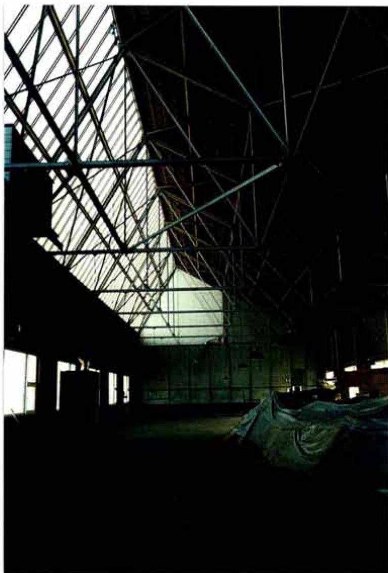
Afb. 21 De eerste verdieping van de eenbeukige hal van gebouw 51, daterend uit 1951-'52. Oorspronkelijk was dit de uitslagvloer. Op de achtergrond is een oorspronkelijke ijzeren tussenwand zichtbaar (afb. 22 en 23).
