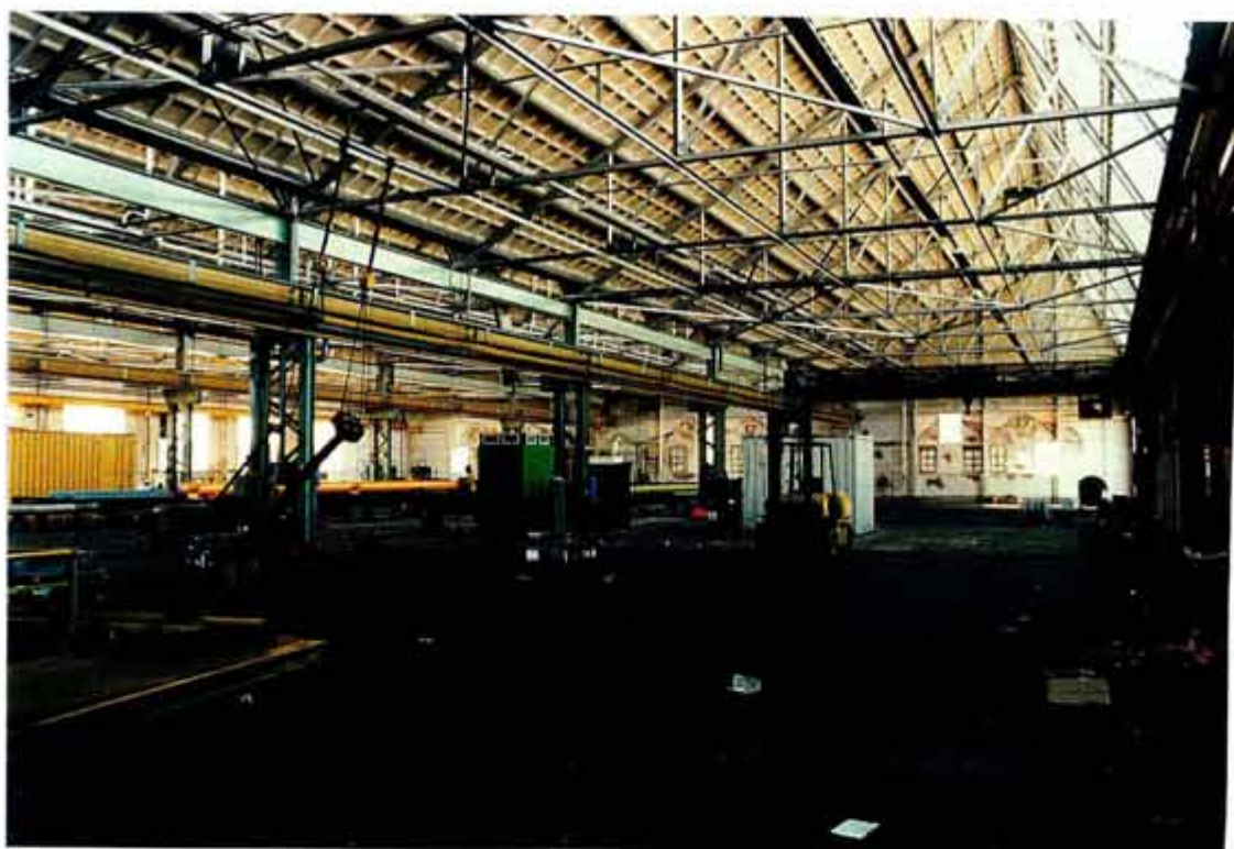
Afb. 17 Overzicht van de lage driebeukige hal van gebouw 51 uit 1938-'39, gezien naar het westen. Als dragers van het staalskelet zijn tussen de drie beuken samengestelde, open kolommen toegepast. De sheddaken zijn aan de noordzijde voorzien van glaspanelen (thans kunststof) en aan de zuidzijde van bimsbetonnen cassetten.
