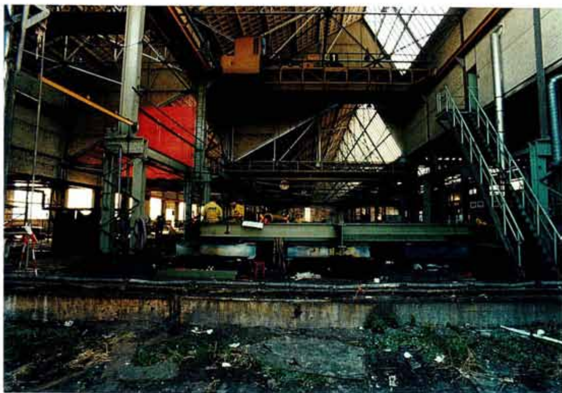
Afb. 19 De korte hoge driebeukige hal van gebouw 51 uit 1938-'39, gezien vanaf de scheepshelling. Oorspronkelijk was deze wand open, maar sedert circa 1948 is de hal afsluitbaar met grote deuren. Daarbij is de laatste travee, die een open overstek vormde, bij de binnenruimte getrokken. Op de achtergrond is de lage driebeukige hal uit 1938-'39 zichtbaar.
