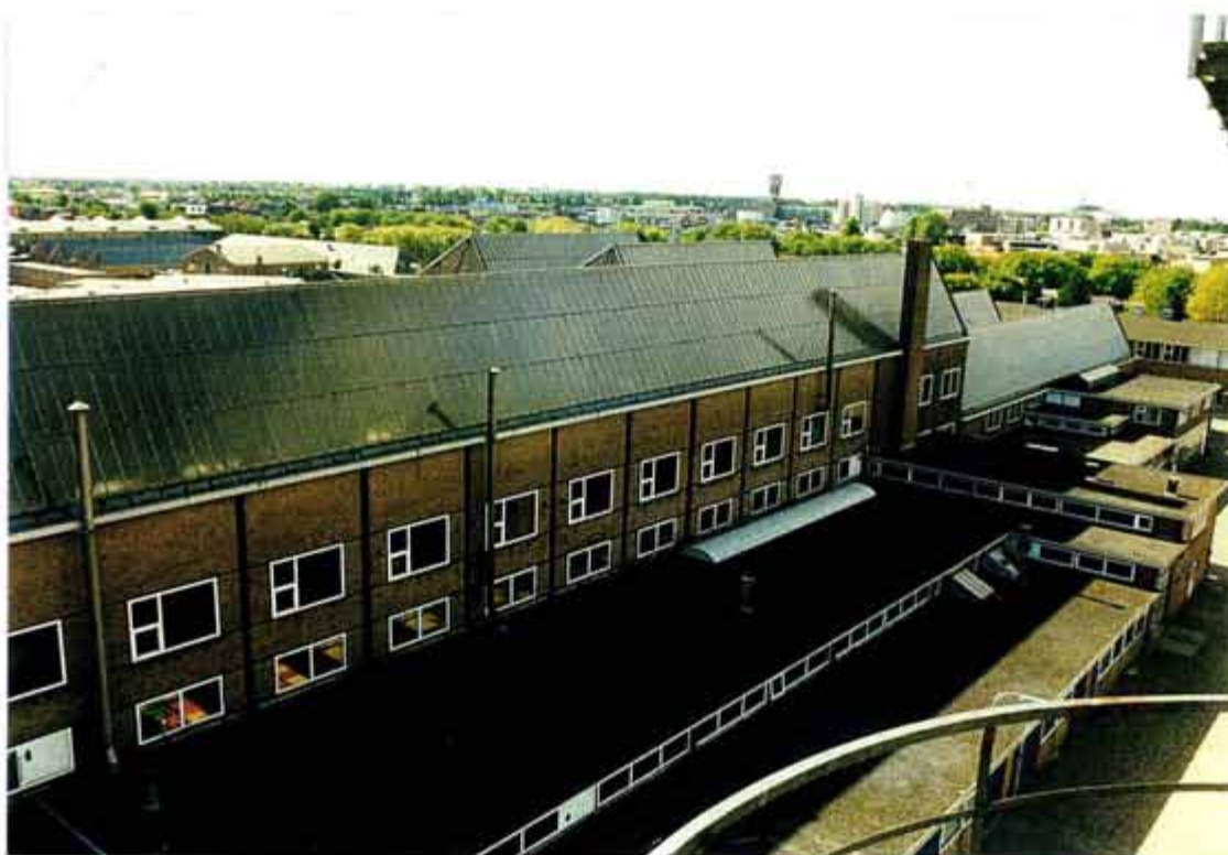
Afb. 14 De noordgevel van gebouw 51, gezien vanaf de kraan bij dok 1. Op de achtergrond is de lage driebeukige hal uit 1938-'39 zichtbaar, met direct daarop aansluitend de korte hoge driebeukige hal uit dezelfde tijd. In het verlengde van de noordelijke beuk van die hoge driebeukige hal is een eenbeukig gebouw opgetrokken in 1951-'52. De lagere aanbouwen met platdak tegen de driebeukige hallen stammen evenals die hallen uit 1938-'39. De lage aanbouw met platdak is tegen het eenbeukige gebouw is in 1951-'52 gebouwd. De oorspronkelijke stalen vensters zijn recent vervangen door kunststof.
