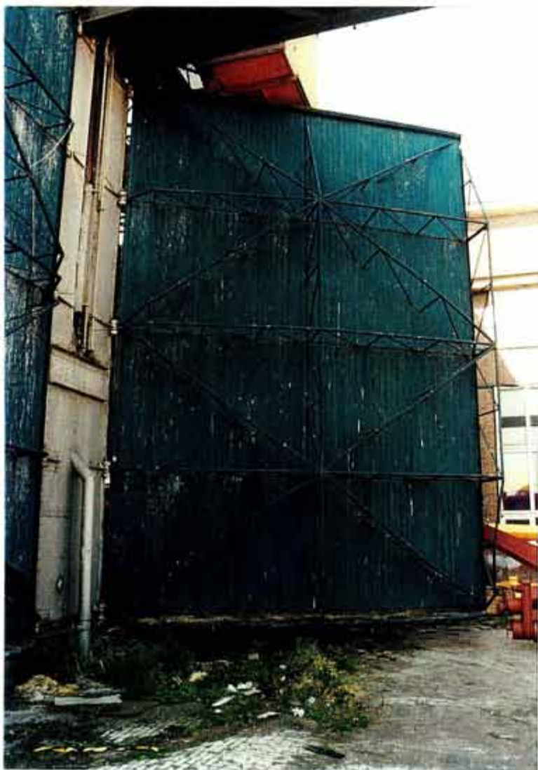
Afb. 20 Eén van de vier deuren in de oostgevel van de korte hoge driebeukige hal van gebouw 51, vermoedelijk daterend uit 1948. Oorspronkelijk was deze hal aan de zijde van de sloopshelling open.
