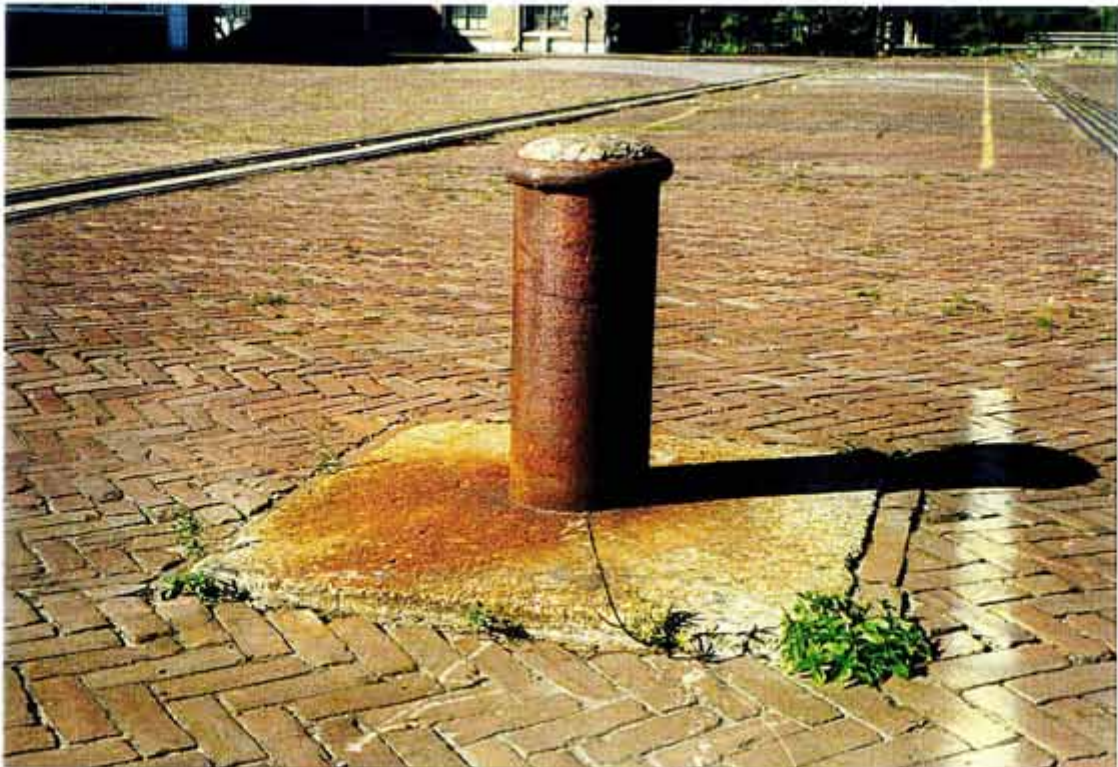
Afb. 7 Meerpaal, bestaande uit een buisprofiel met betonvulling, type B (zie afb. 1).
