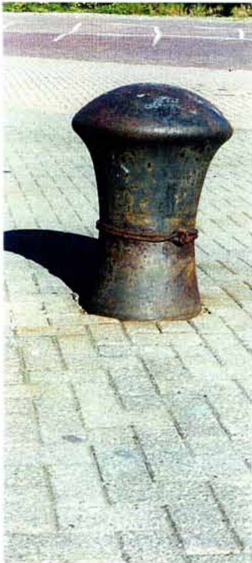
Afb. 5 (links) Een gietijzeren meerpaal, type D (zie afb. 1).
