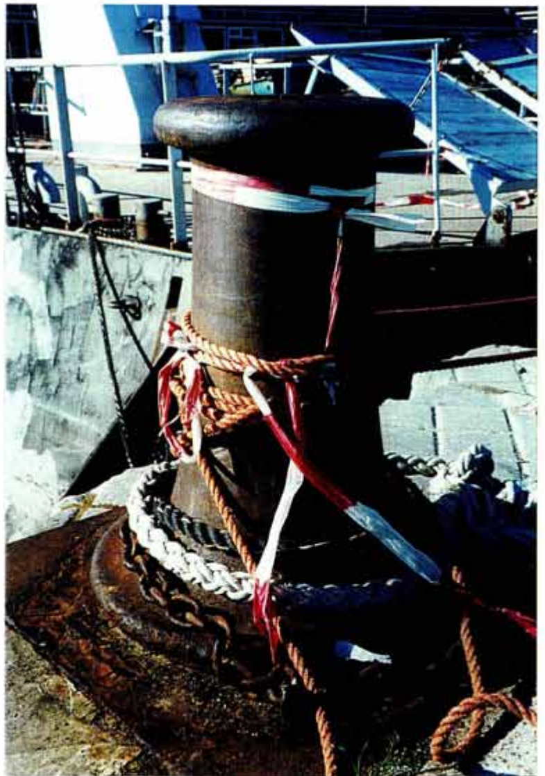
Afb. 5 (links) Een gietijzeren meerpaal, type D (zie afb. 1).
