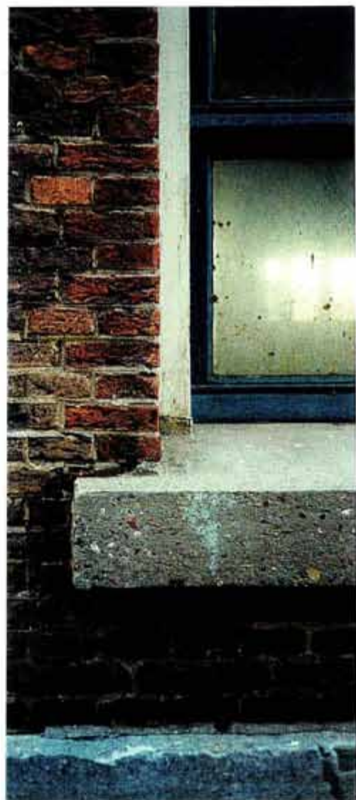
Afb. 18 (links) Venstertype 3 (1958). De hoofdvorm van het venster is gelijk aan het oorspronkelijke venster (afb. 12), maar de detaillering wijkt op een aantal punten af. Kenmerkend zijn de onregelmatigheden in het metselwerk, waarbij lichtrode handvormstenen zijn gebruikt. De sluitsteen in de anderhalfsteensrollaag en de onderdorpel zijn van beton.
