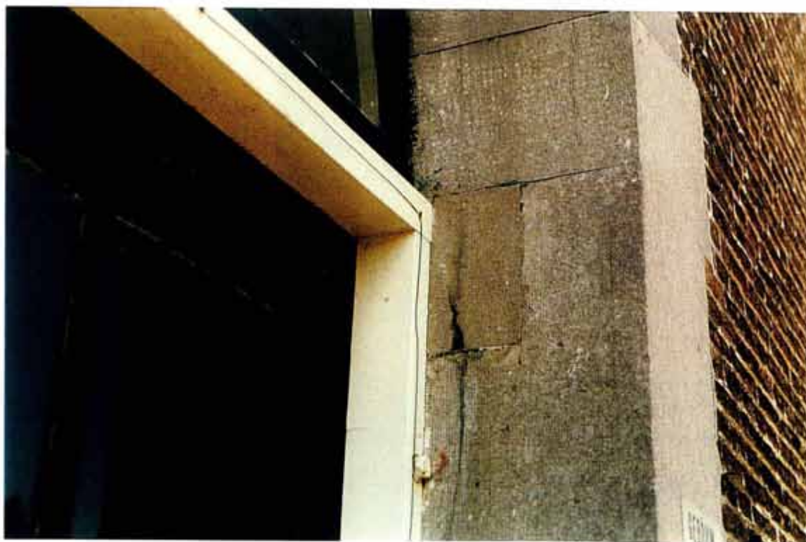
Afb. 22 Detail van het kalf bij een gemoderniseerde deur, waarschijnlijk daterend uit 1949. In de hardstenen negge is de moet van het verwijderde oorspronkelijke kalf uit 1824 zichtbaar (vergelijk afb. 21).
