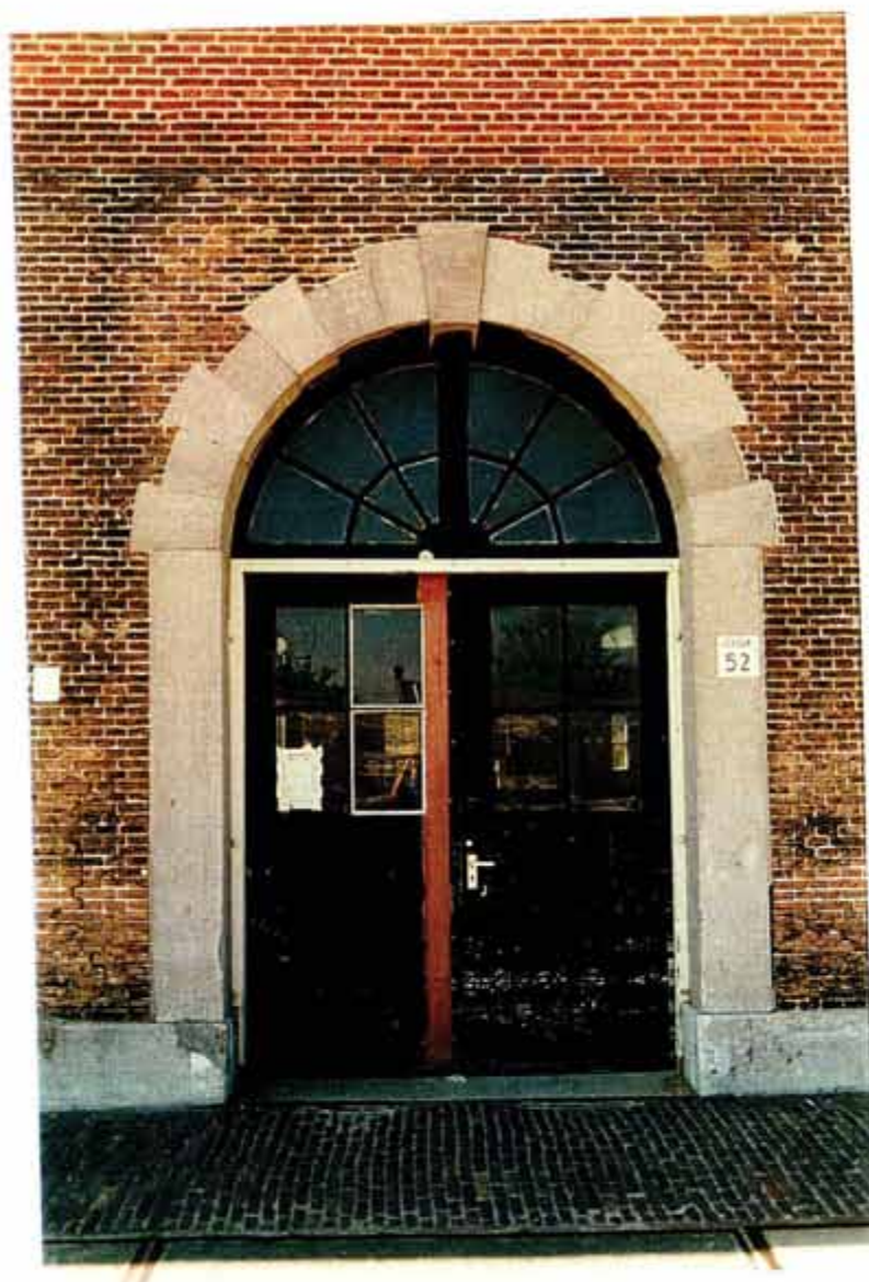
Afb. 20 Uit de bouwtijd (1824) daterende hardstenen deuromlijsting in de oostgevel. Het kozijn, de deuren en het bovenlicht dateren mogelijk van een verbouwing uit de eerste helft van deze eeuw.
