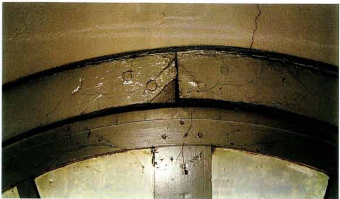
Afb. 14 (boven) Detail van het bovenlicht van één van de oorspronkelijke vensters in de westgevel, gefotografeerd op een omloop op de begane grond. Het kozijn is uit vier gebogen delen samengesteld.
