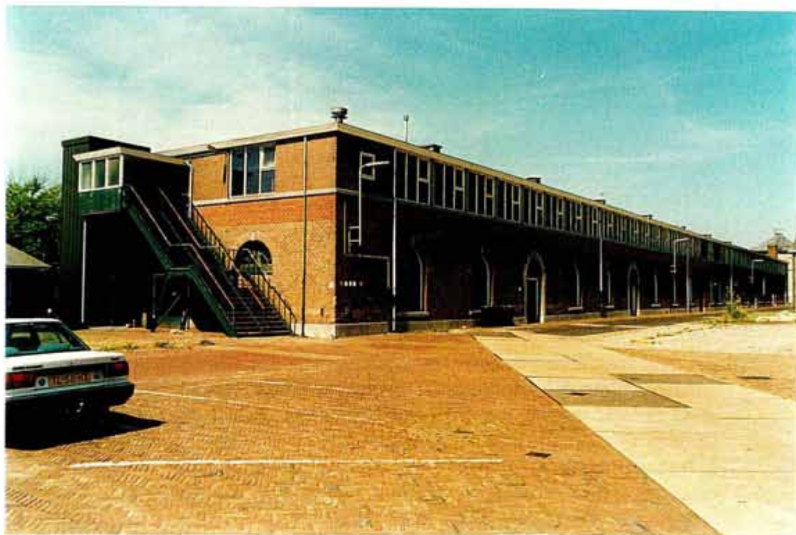
Afb. 8 (boven) Overzicht van het gebouw vanuit het zuidwesten. De begane grond dateert nog uit 1824, de verdieping uit 1958.
