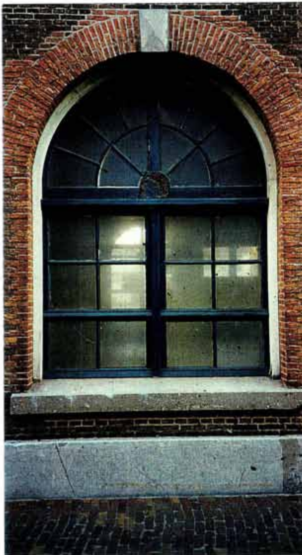
Afb. 18 (links) Venstertype 3 (1958). De hoofdvorm van het venster is gelijk aan het oorspronkelijke venster (afb. 12), maar de detaillering wijkt op een aantal punten af. Kenmerkend zijn de onregelmatigheden in het metselwerk, waarbij lichtrode handvormstenen zijn gebruikt. De sluitsteen in de anderhalfsteensrollaag en de onderdorpel zijn van beton.
