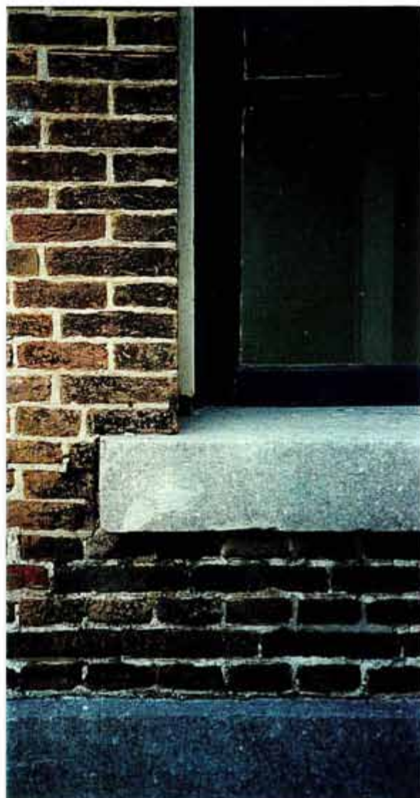
Afb. 12 (links) Venstertype 1 (1824). Het raam heeft oorspronkelijke dagkanten, een anderhalfsteens rollaag met een diamantkopvormige hardstenen sluitsteen en een hardstenen dorpel. Het kozijn valt vrijwel achter het metselwerk weg. De boog van het kozijn bestaat uit 3 schenkels.
