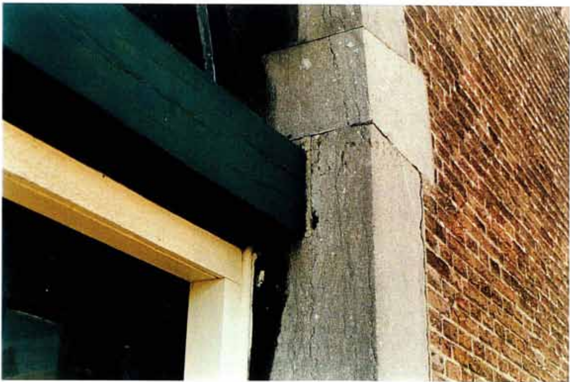
Afb. 21 Detail van het kalf bij de deuromlijsting in de oostgevel. Het zware houten kalf van de oorspronkelijke deur (1824) is in een inkassing van de hardstenen omlijsting opgenomen (vergelijk afb. 22).
