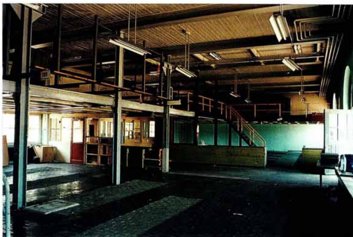
Afb. 24 (boven) Overzicht van de ruimte in het zuidelijke kopeinde van gebouw 52. In de omloop op de voorgrond zijn balken uit 1824 hergebruikt.
