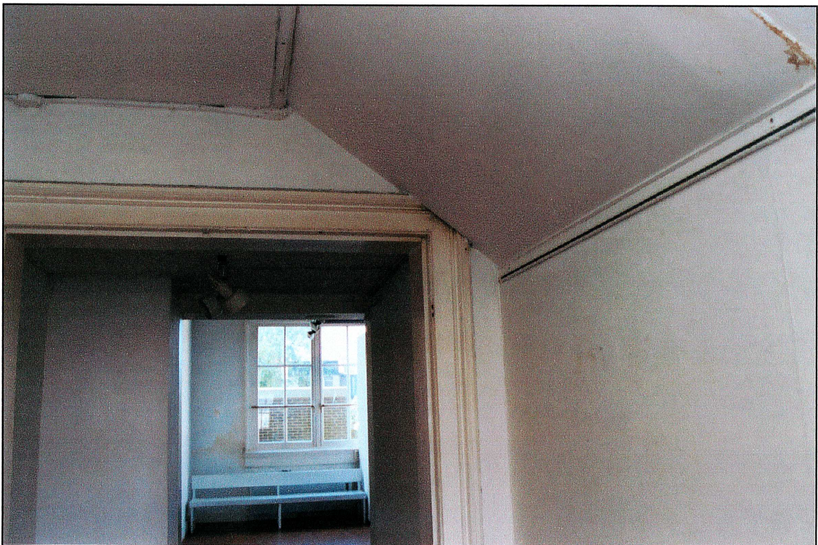
Afb. 24 [boven]: De achterwand van het lokaal linksvoor (BG) met restant van de scheidingswand.
