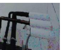
PRINCIPE MUURDOORVOER DAKBEDEKKING t.b.v. flexibele koelleidingen / bekabeling
