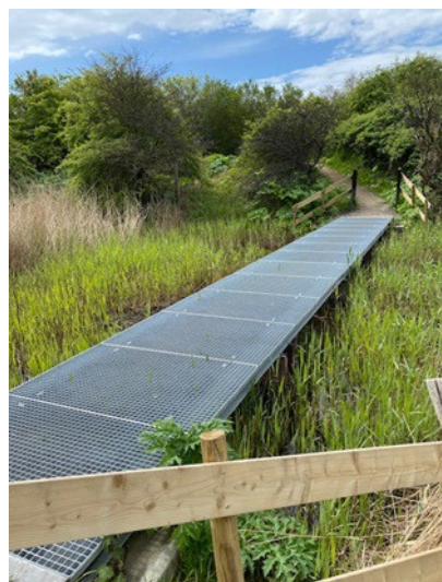
Nieuwe brug bij fort Dirksz Admiraal
