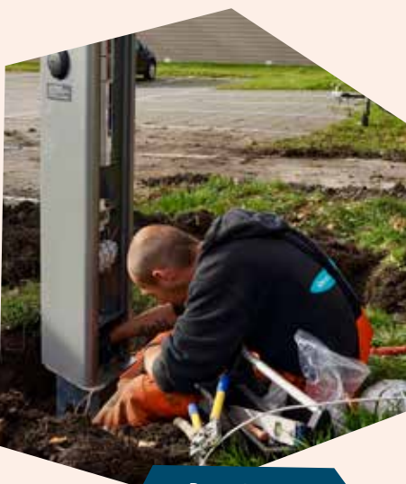
De aanleg van een laadpaal
