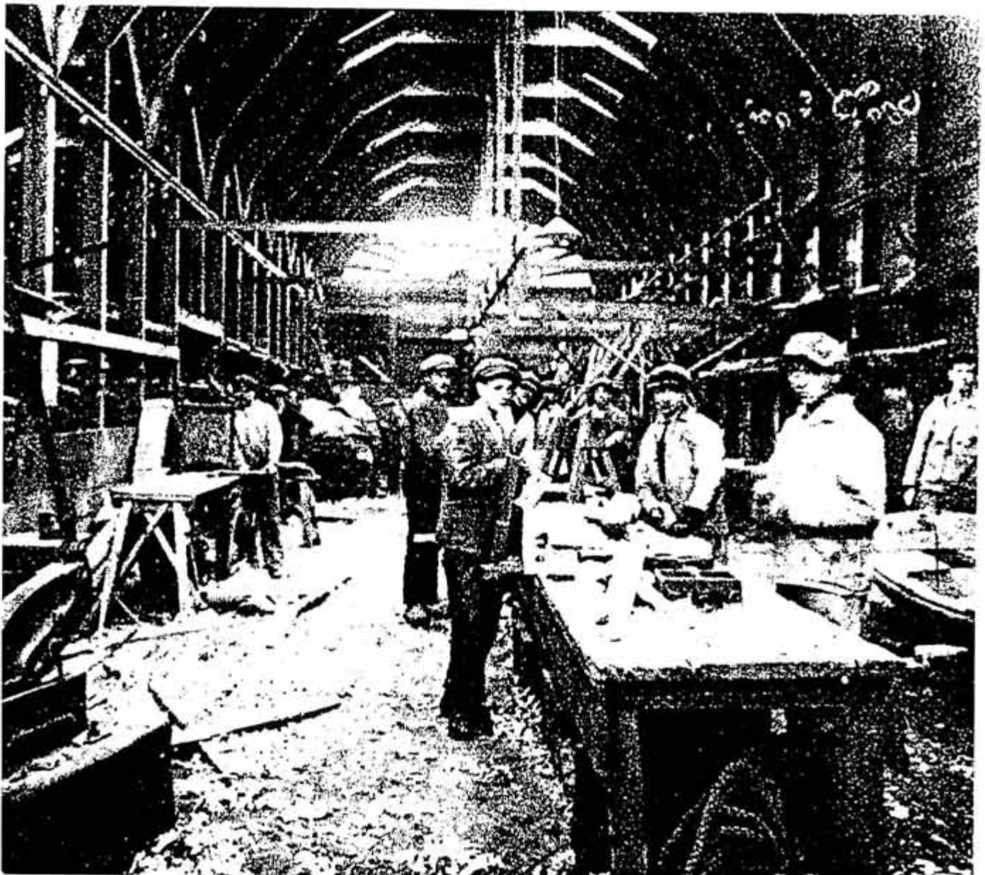
Afb. 7 Interieur van één van de loodsen van de sloepenloods, vóór 1936. In 1936 werden de op deze foto nog afwezige ijzeren trekstangen aangebracht ter versteviging van de constructie (zie afb. 12). Het bovenlicht in de kopgevel is nog open. Aan de kolommen zijn schotten, latten en andere constructies bevestigd. (Herkomst: Instituut voor Maritieme Historie)
