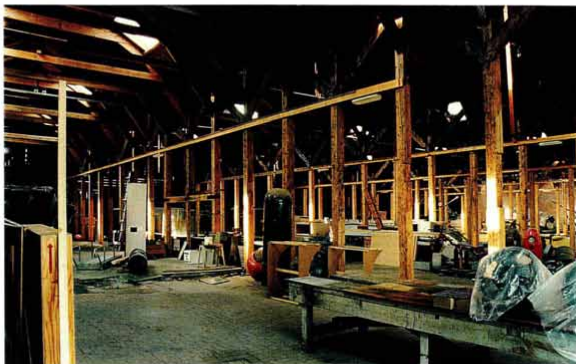
Afb. 13 (boven) Interieur van loods 15 van de sloepenloods, te zien naar het zuiden. De trekbalen in de constructie dateren uit circa 1949, evenals de bakstenen muur links op de foto.
