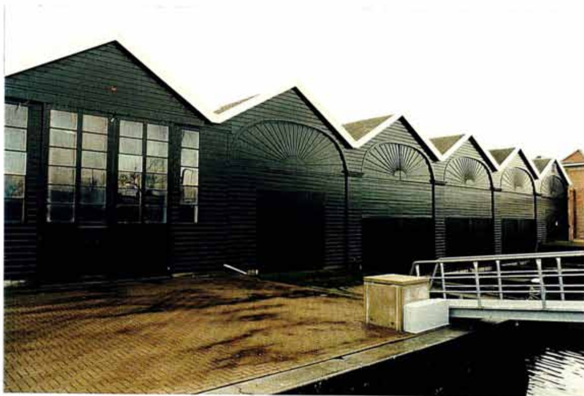
Afb. 8 Noordgevel van de sloepenloods, die in deze opzet grotendeels uit 1881-'82 dateert. Wel zijn sindsdien de deuren gewijzigd of vervangen en de bovenlichten vernieuwd.
