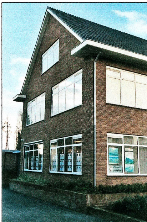
Afb. 19. Rechter geveltop met Noords verband en geblokte vlechtingen langs de dakrand.
