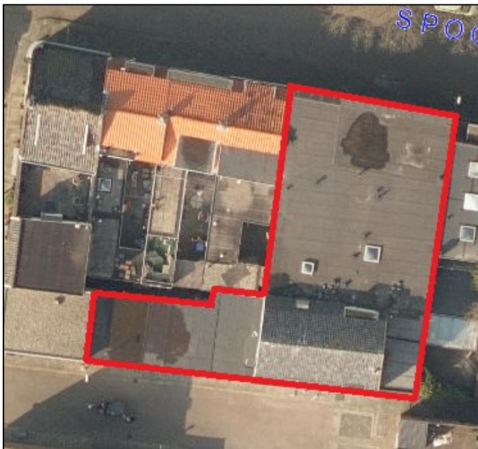
figuur 1: Luchtfoto met binnen de rode lijnen het pand aan de Spoorgracht 24, Gasstraat 5, 5a en 5b en bij de aanvraag van 4 maart 2020 betrokken garageboxen.
