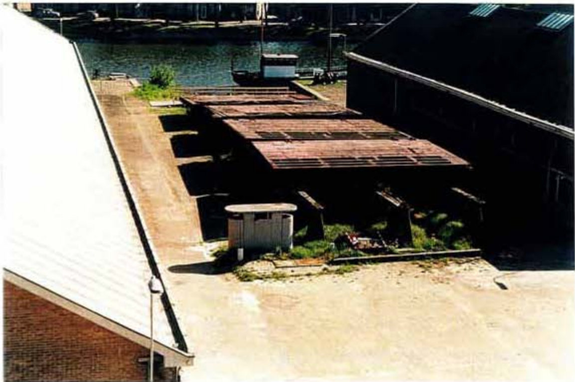
Afb. 1 (boven) Bovenaanzicht van de sluisdeurenhelling met de vier reserve sluisdeuren voor het Dokkanaal of Boerenverdriet. Links is het dak van gebouw 73 zichtbaar, rechts een gedeelte van gebouw 66.
