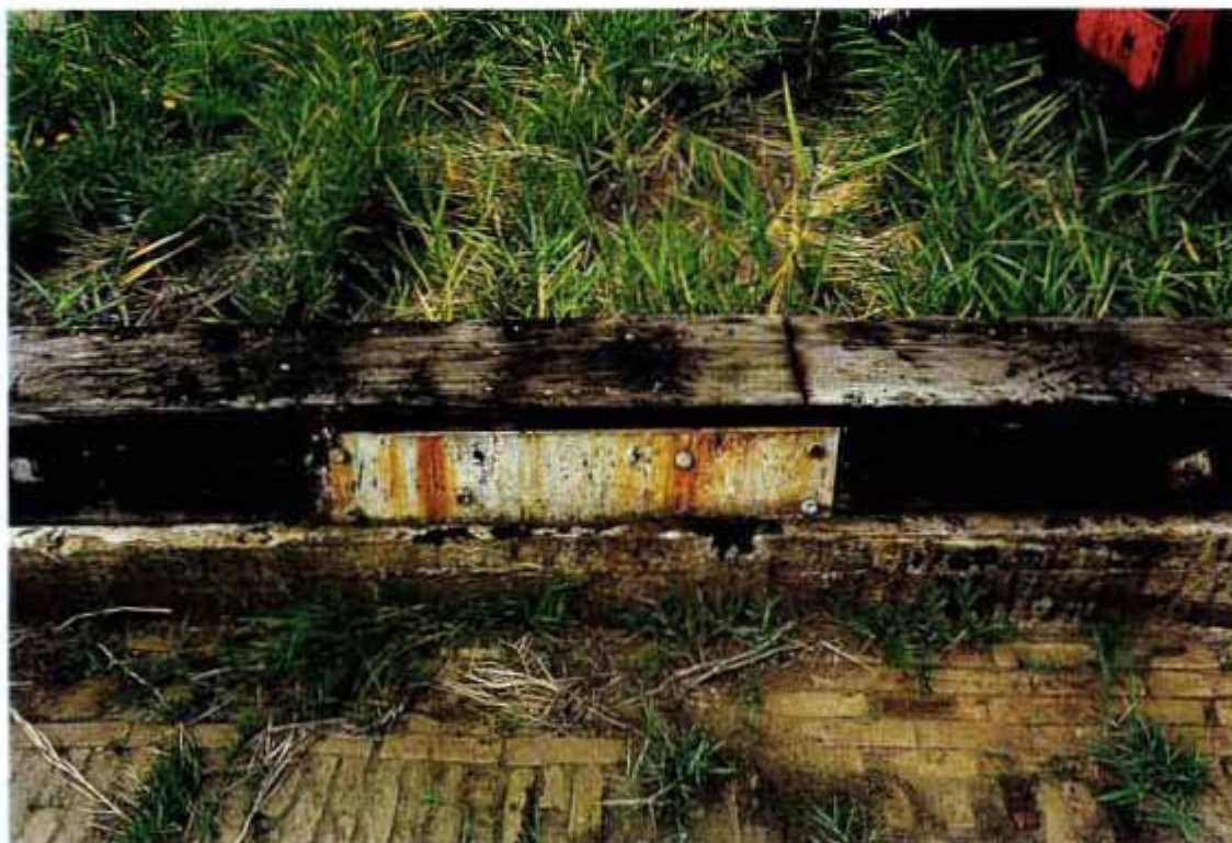
Afb. 3 (boven) Het onderste gedeelte van de sluisdeurenhelling met de drie houten geleide-balken, gezien naar het zuiden. De middelste geleide-balk heeft een reeks inkepingen, vermoedelijk samenhangend met een remfunctie.
