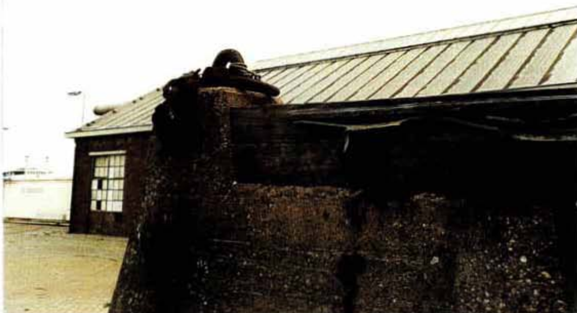
Afb. 7 (boven) Het bovenste deel van de houten geleide-balken steunt op betonnen poeren. De ijzeren reserve-sluisdeuren liggen op houten wiggen.
